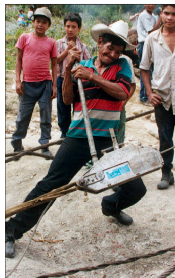
Und hier in Ecuador beim Einsatz im Brückenbau.
